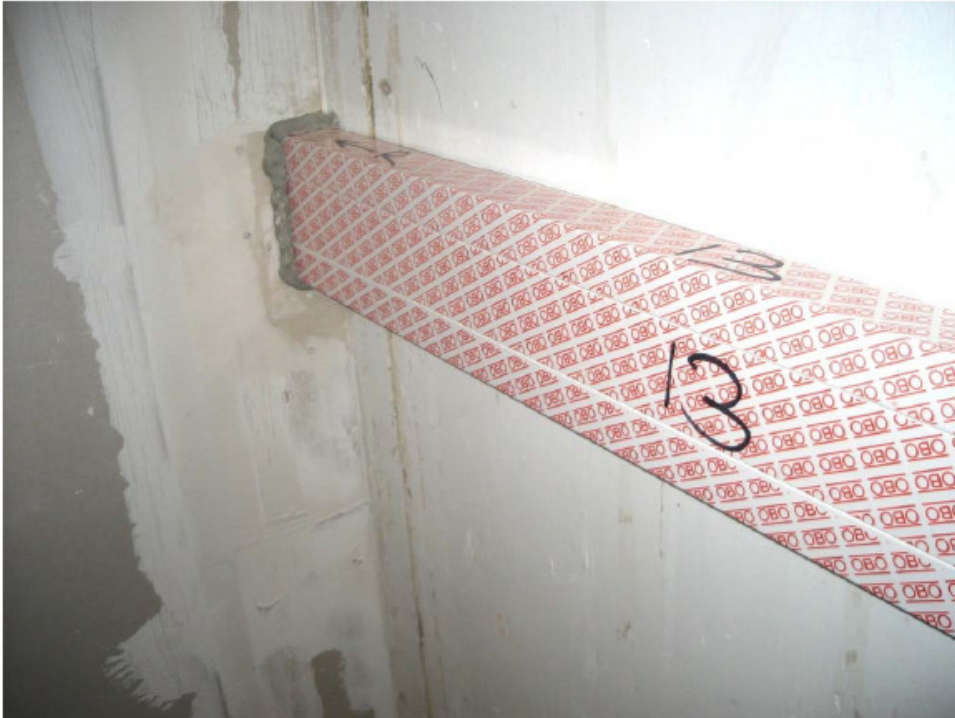
Geräteeinbaukanal aus PVC, Kanal leer
